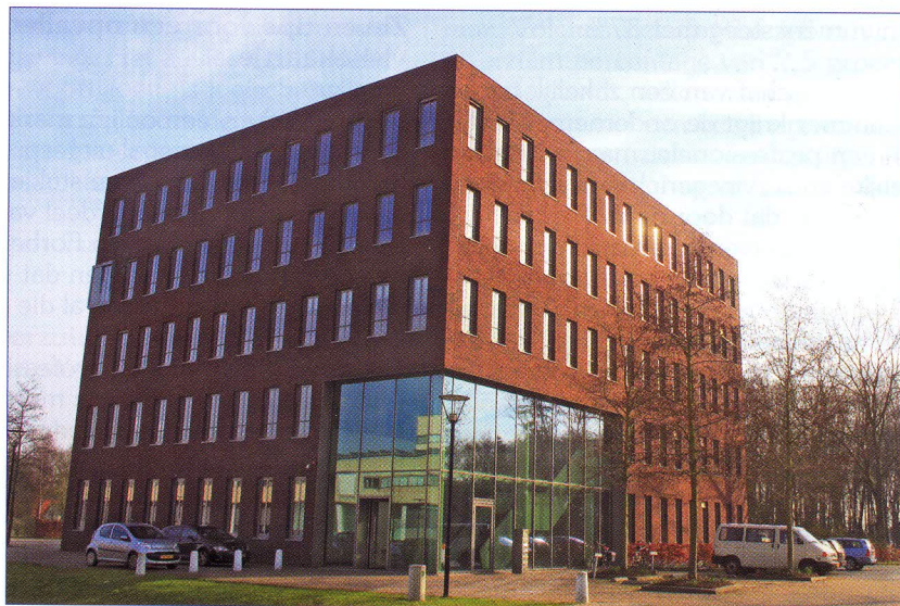
Octrooibureau Vriesendorp & Gaade, gevestigd op de eerste verdieping van dit kantoorpand op Business Park Apeldoorn.
